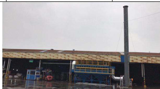
图 2 两器破碎抽条、切割粉尘处理设施排气筒
