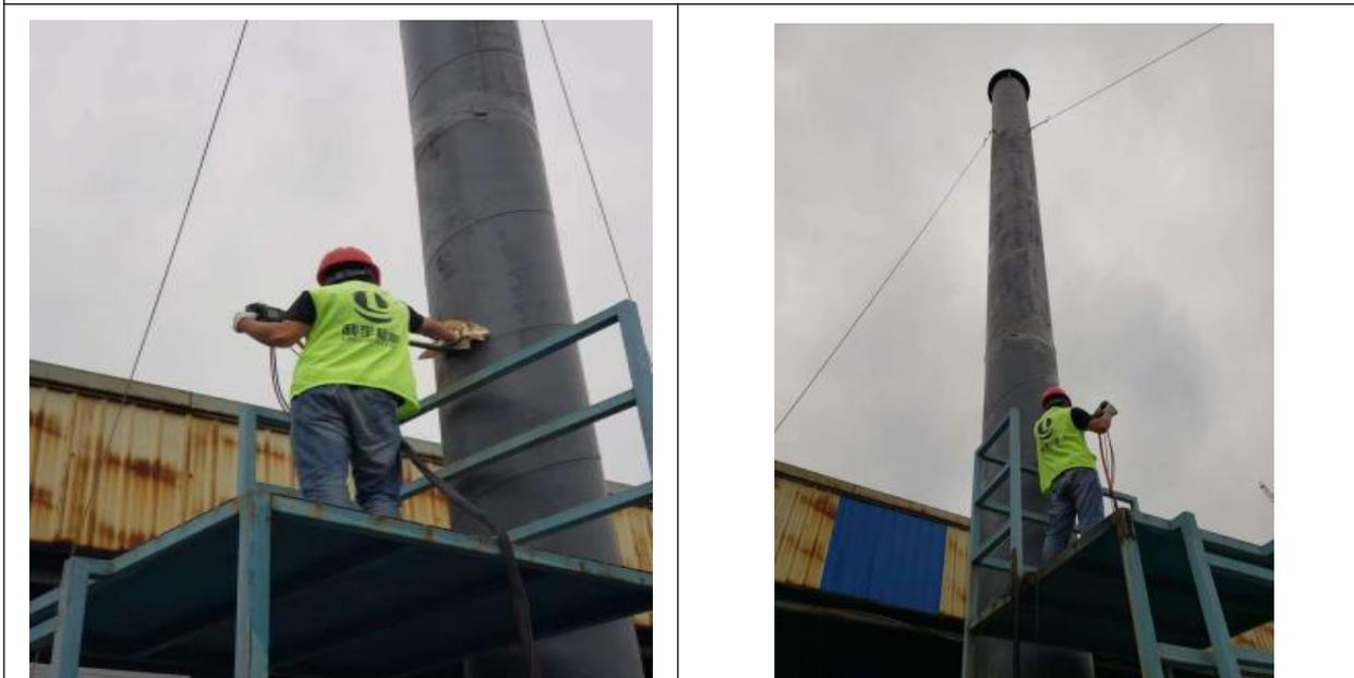
图 6 偏转线圈破碎粉尘排气筒采样口及采样平台
