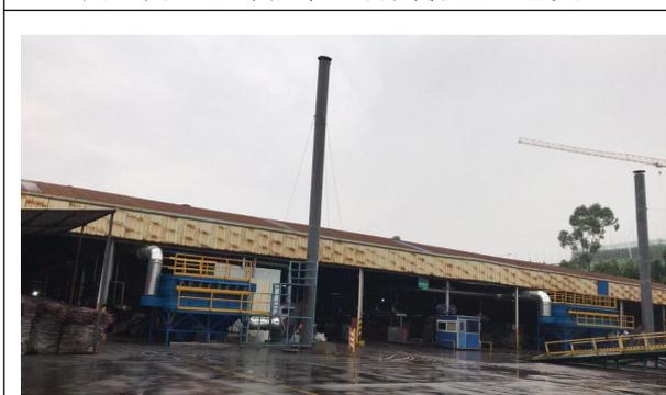
图 3 两套废气处理设施排气筒
