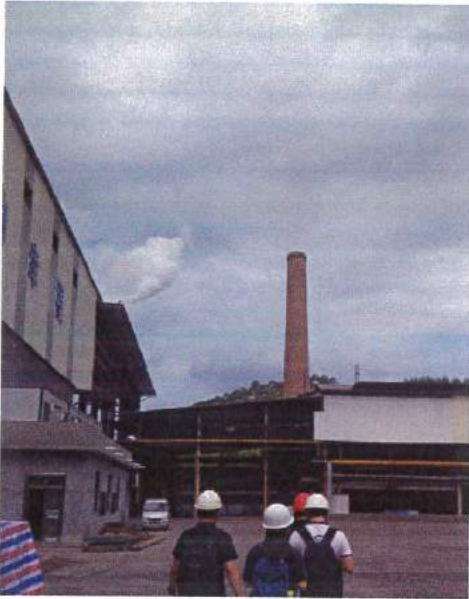
加热炉废气排气筒
